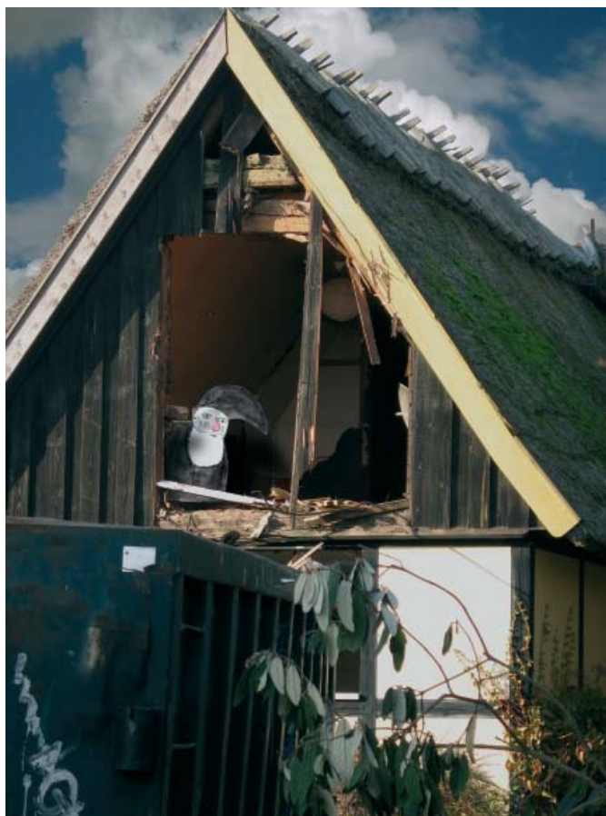
En forskræmt nisse kigger ud ad loftslugen under nedrivningen.
