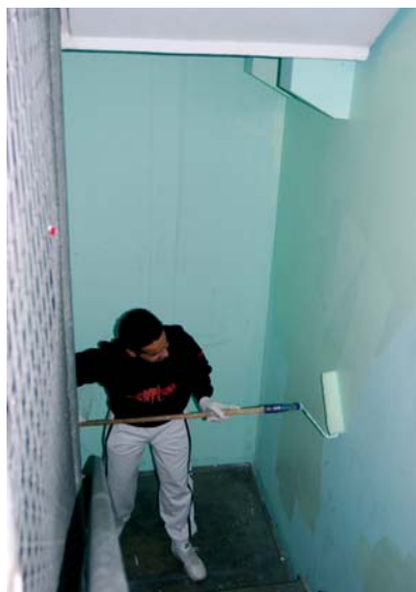
En ung igang med malerarbejdet.
