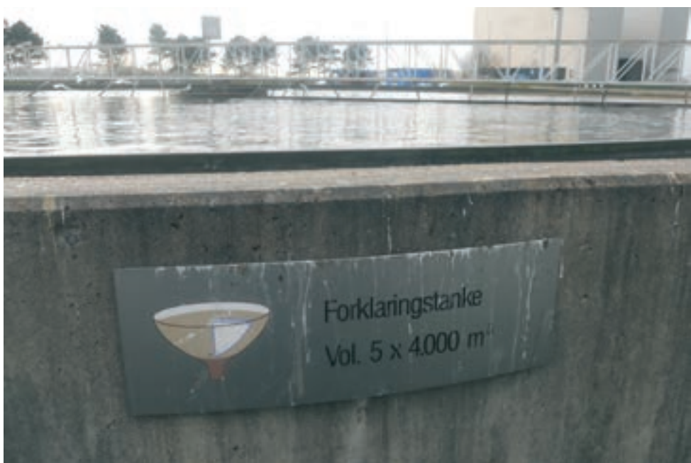
Til sidst bliver spildevandet rensat for fast organisk stof i en såkaldt forklaringstank.
