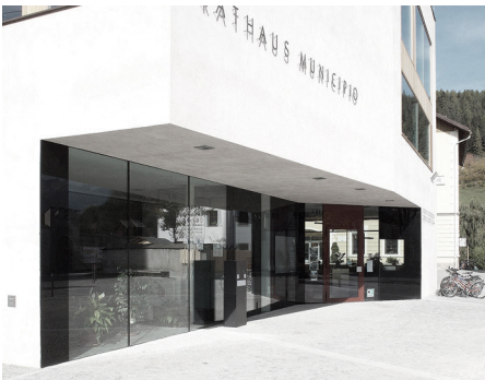
Tilbagetrækning i facaden
