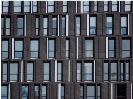
Stålplader, New York. Ark : SHOP architects
