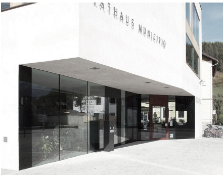
Tilbagetrækning i facaden
