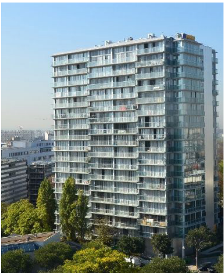
Facader renovering af boligblok. Vinterhave og altan tilføjes eksisterende beton højhus, Paris. Ark: Lacaton & Vassal Architects
