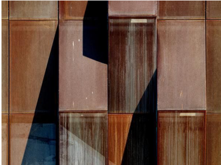
Cortenstål, Tyrkiet. Ark: Emre Arolat Architects
