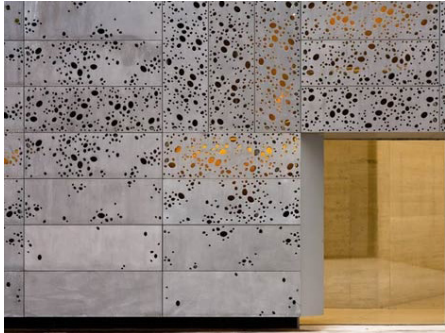
Perforerede stålplader, Spanien. Ark: Nieto Sobejano
