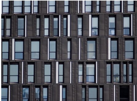
Stålplader, New York. Ark : SHOP architects
