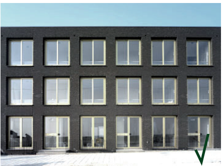
Jævn vinduesrytme, Amsterdam .Ark: Claus En Kaan
