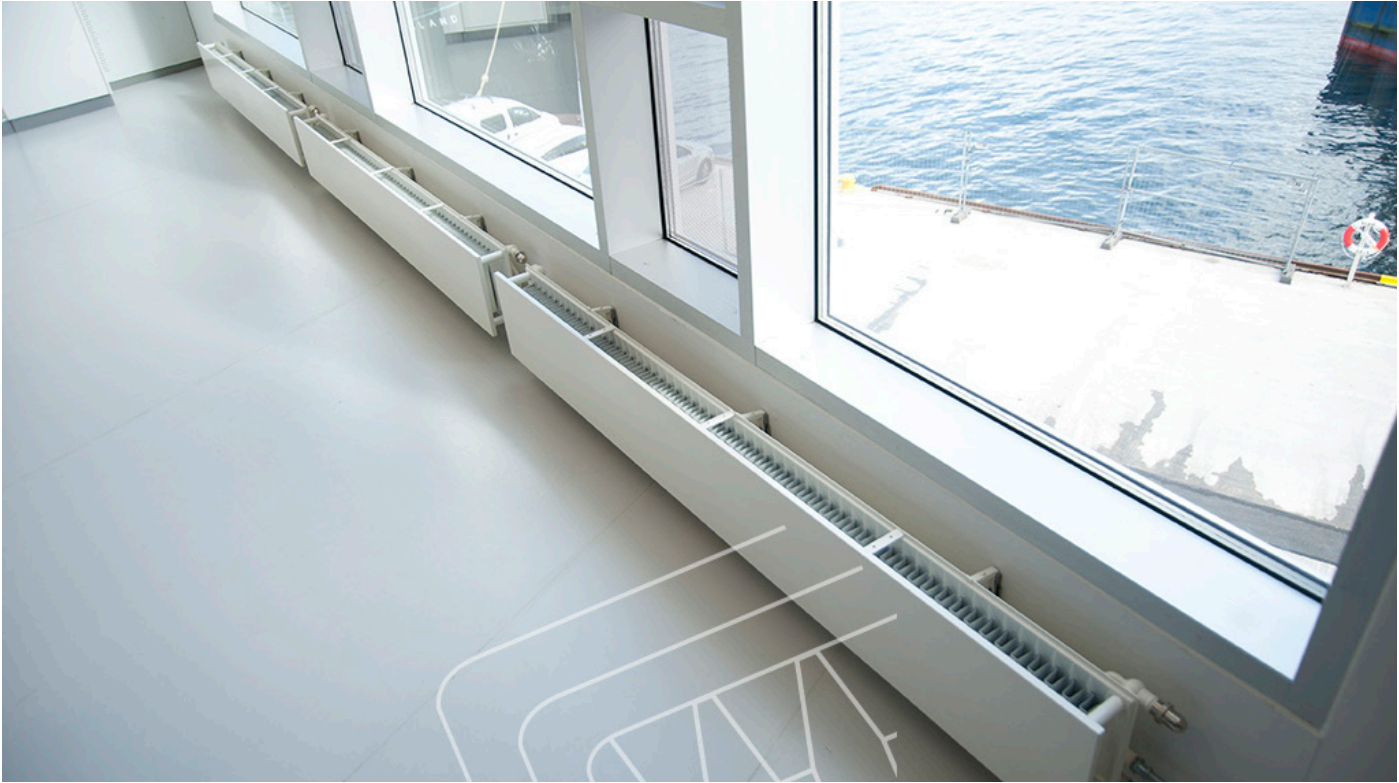
De eksisterende radiatorer og varmerør udskiftes til nye med varmemålere.
