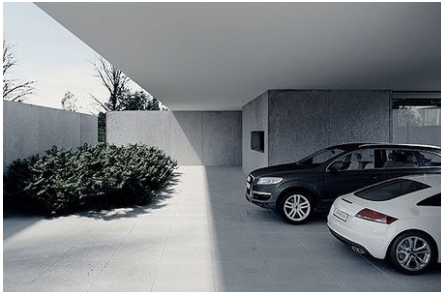
Visuel kontakt med omkringliggende område, Polen. Ark : Tamizo Architects Group
