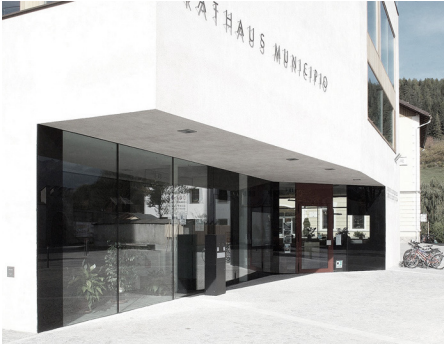
Tilbagetrækning i facaden
