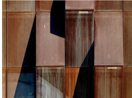
Cortenstål, Tyrkiet. Ark: Emre Arolat Architects
