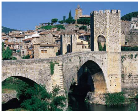
Besalus infrastruktur, byrum og arkitektur er bygget op i lokale materialer.
