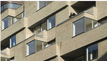
Horisontal teglfacade med hjørnevindue og altan, København. Ark : C.F.Møller
