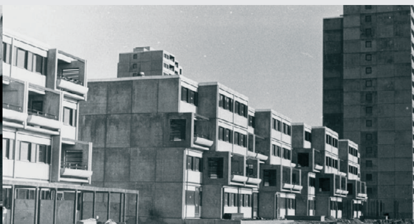
Brøndby Strand under anlæg ca. 1970
