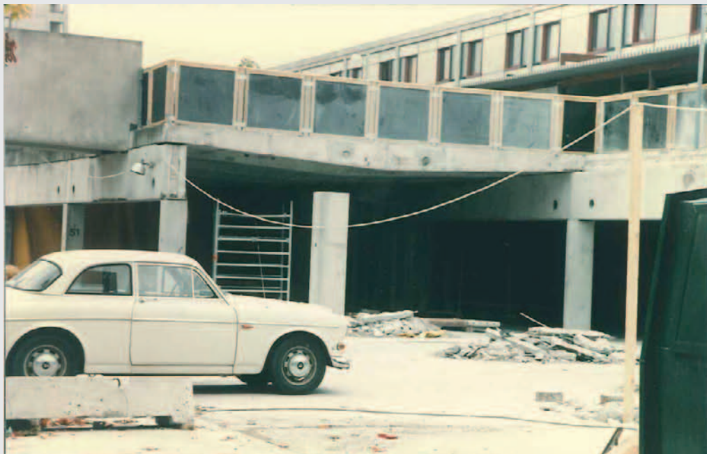
"Betongraven" i et af højhusenes parkeringskælder
