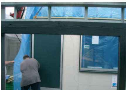
De gamle facadeplader fjernes.
