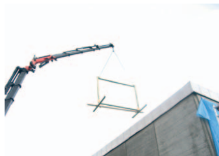
Der monteres nye facadeplader.
