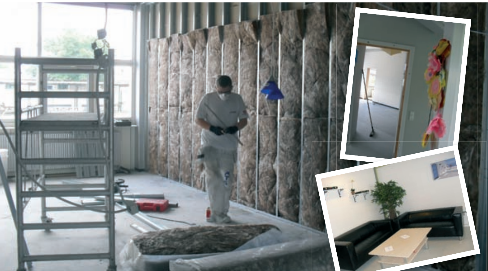
Fra byggeplads til hyggeligt indrettede lokaler. Langbjergskolen undergår i efteråret en større renovering.
