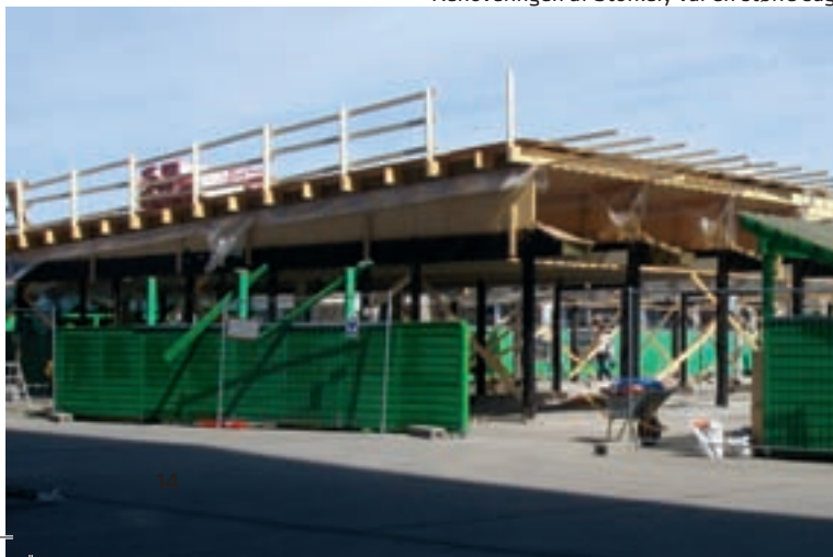
Renoveringen af Storkely var en større sag
