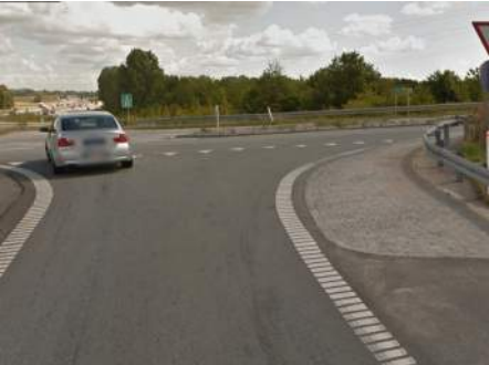
Vejbanen er indsv  vret for at reducere hastigheden. Der er dog tilf  rt alternativ bel  gning hvor vejen svinger, s   lastbiler og k  ret  jer med st  rre svingradius ogs   kan benytte vejen.
