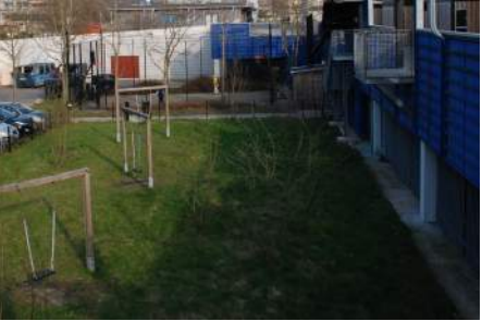
Legepladser i parkeringsniveau besværliggør opsyn
