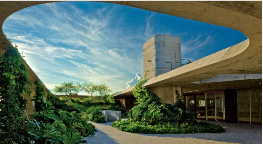
Plantebed i parkeringskælder
