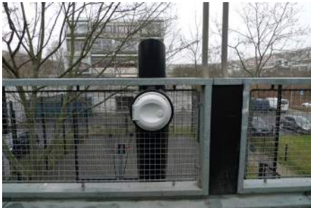
Skakte til husholdningsaffald er allerede etableret ved rækkehusene. Nedkast sker fra strædets niveau. Tømning fra parkeringsniveau, hvor renovationskøretøjerne let kan komme til. Kildesortering kan etableres på samme måde.
