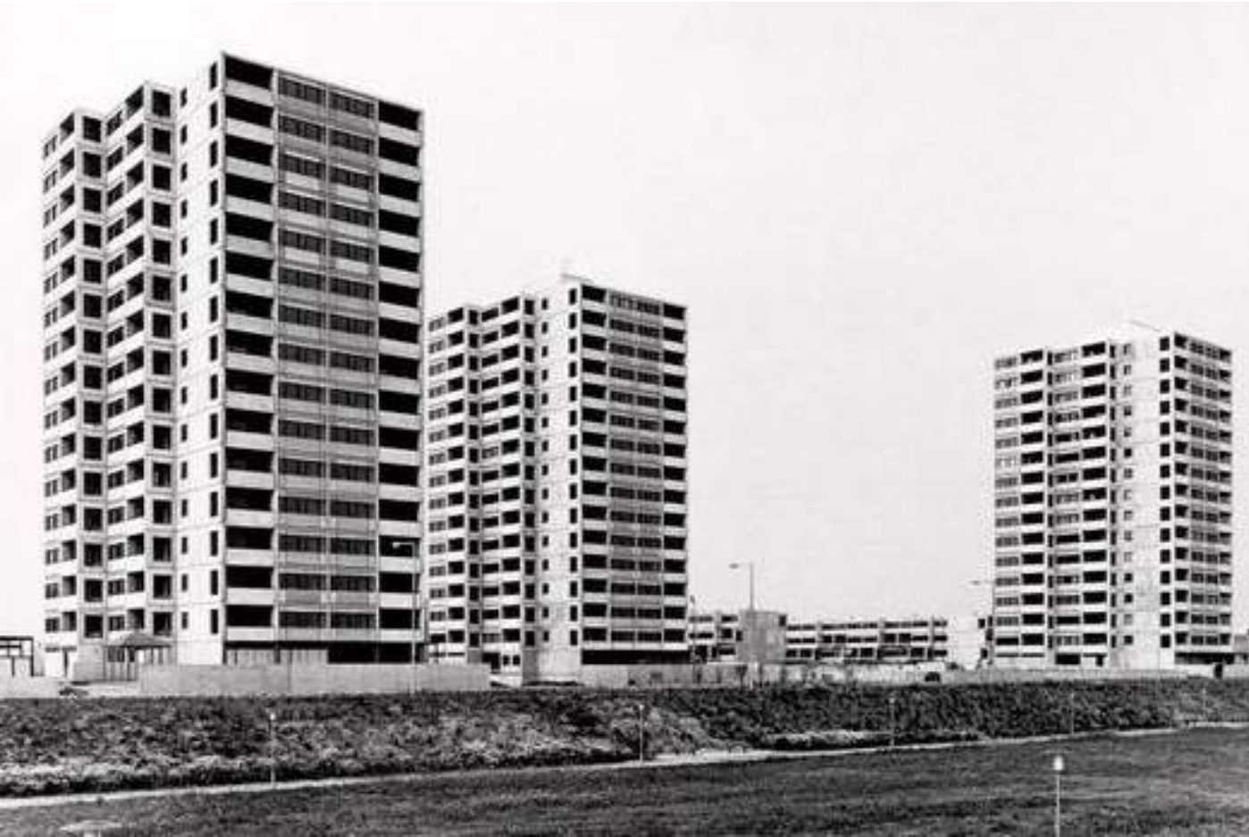
Det originale Brøndbystrandpark
