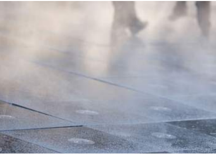
Vanddamp i belægning som på Solbjergplads, SLA
