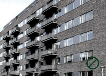
Horizontale vinduesbånd bundet sammen med blændpartier, København. Ark : Triarc Arkitekter.
