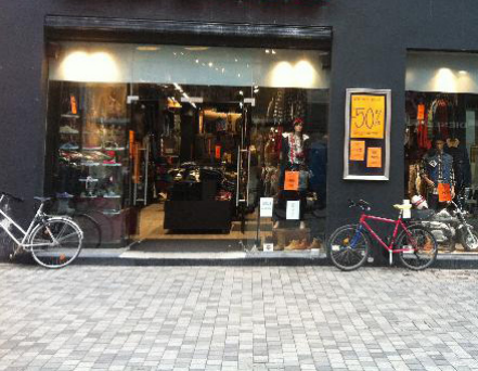
Belægning trukket ind til facaden, Købmagergade
