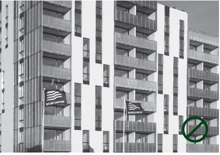
Vertikale vinduesbånd bundet sammen med blændpartier, København. Ark : SHL.
