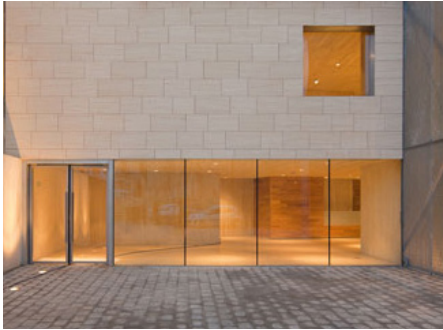
Transperans i facaden. Hellín. Albacete,Spanien. Ark: EXIT architects
