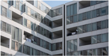
Horisontale fiberbeton facader med indbyggede altaner. Ark: SANAA
