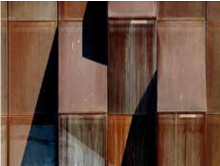
Cortenstål, Tyrkiet. Ark: Emre Arolat Architects
