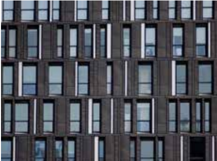
Stålplader, New York. Ark : SHOP architects
