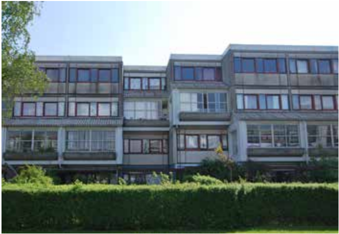
Eksisterende vestfacade De oprindelige åbne altaner er blevet inddækket under tidligere renovering
