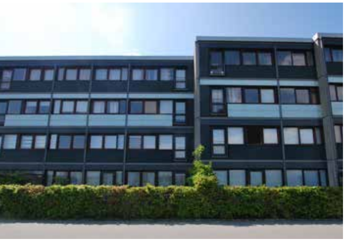
Eksisterende nordfacade Facaden er blevet renoveret tidligere. Vinduerne er dog ikke blevet skiftet, bortset fra dem, der er fjernet for at gøre plads til de franske altaner.
