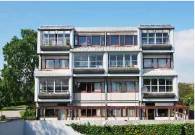
Eksisterende sydfacade Eneste facade med inddækkede altaner på både 1., 2. og 3. sal
